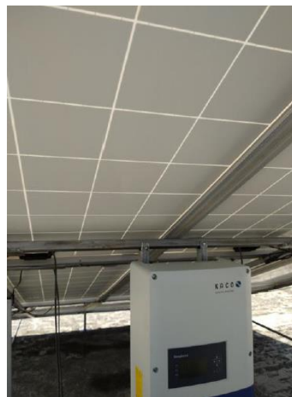
Figura 8. Instalación del Inversor marca KAKO de 3.0 Kw dentro del sistema.
